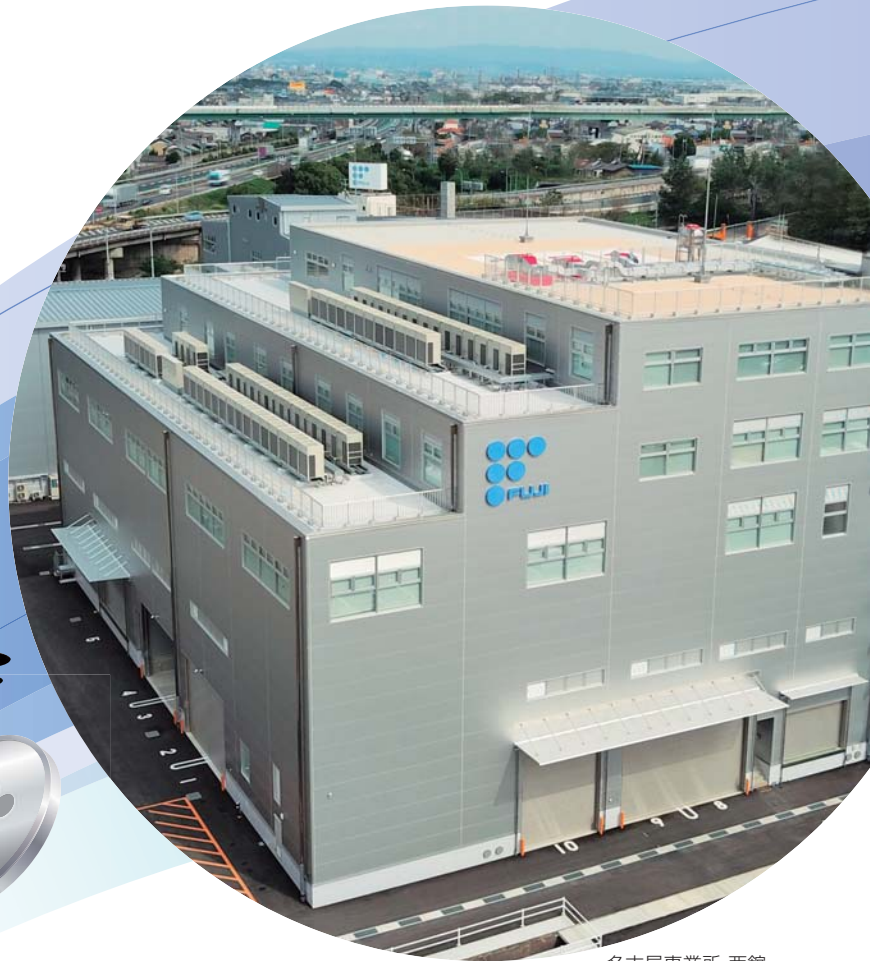
名古屋事業所 西館 (2017年8月竣工)
